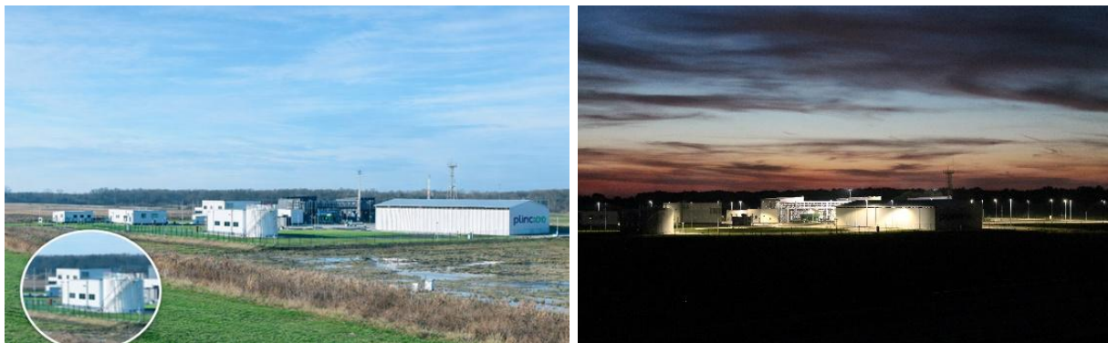
Slika 11. Kompresorska stanica Velika Ludina nakon završetka izgradnje
