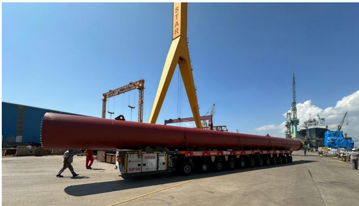
Slika 5. Transport predfabriciranog kesona do mjesta ugradnje na FSRU brodu
