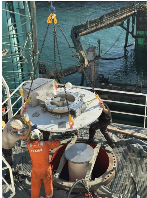
Slika 6. Ugradnja gornje ploče na ulazni niz cijevi pumpe morske vode
